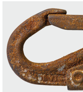
Corrosion / cracks / nicks / gouges
